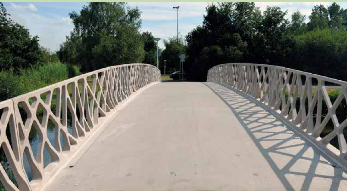
De USHB-brug die in Eindhoven is geplaatst kan gemakkelijk op een andere plek dezelfde functie vervullen.
