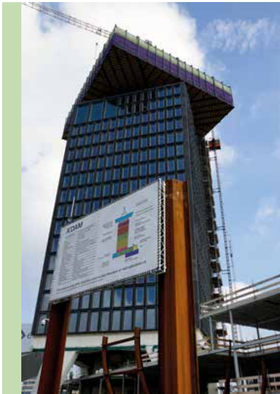
De nieuwe kroon op de top was zwaarder waardoor de oude gevelelementen niet hergebruikt konden worden in dit project.
